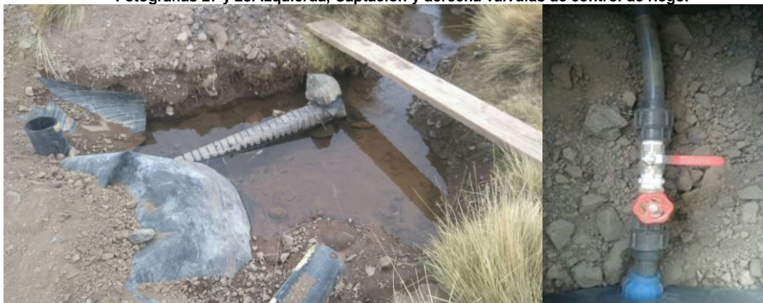
Fotografías 27 y 28. Izquierda, Captación y derecha válvulas de control de riego.
