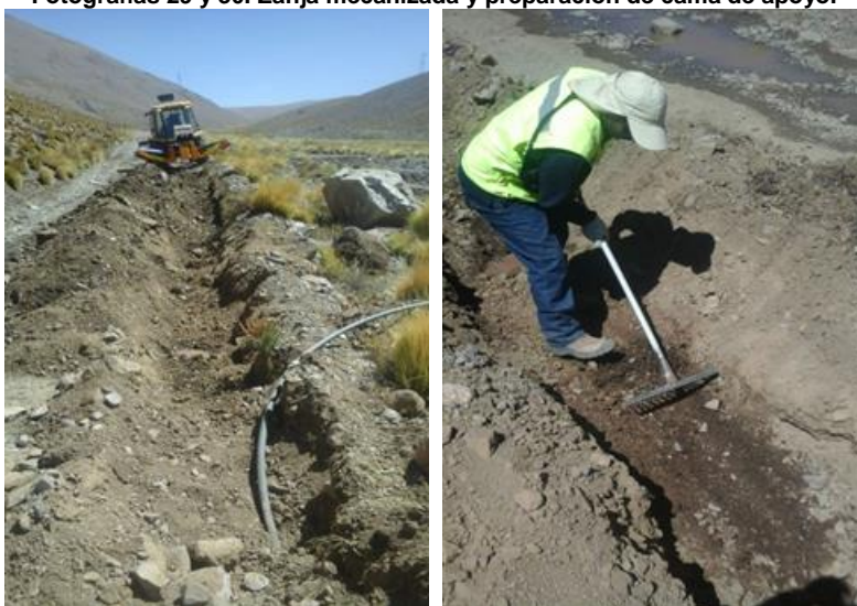
Fotografías 29 y 30. Zanja mecanizada y preparación de cama de apoyo.
