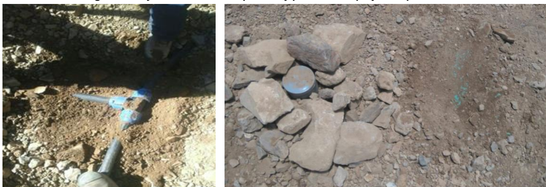
Fotografías 31 y 32. Unión de compresión y protección tipo jumbo para válvulas
