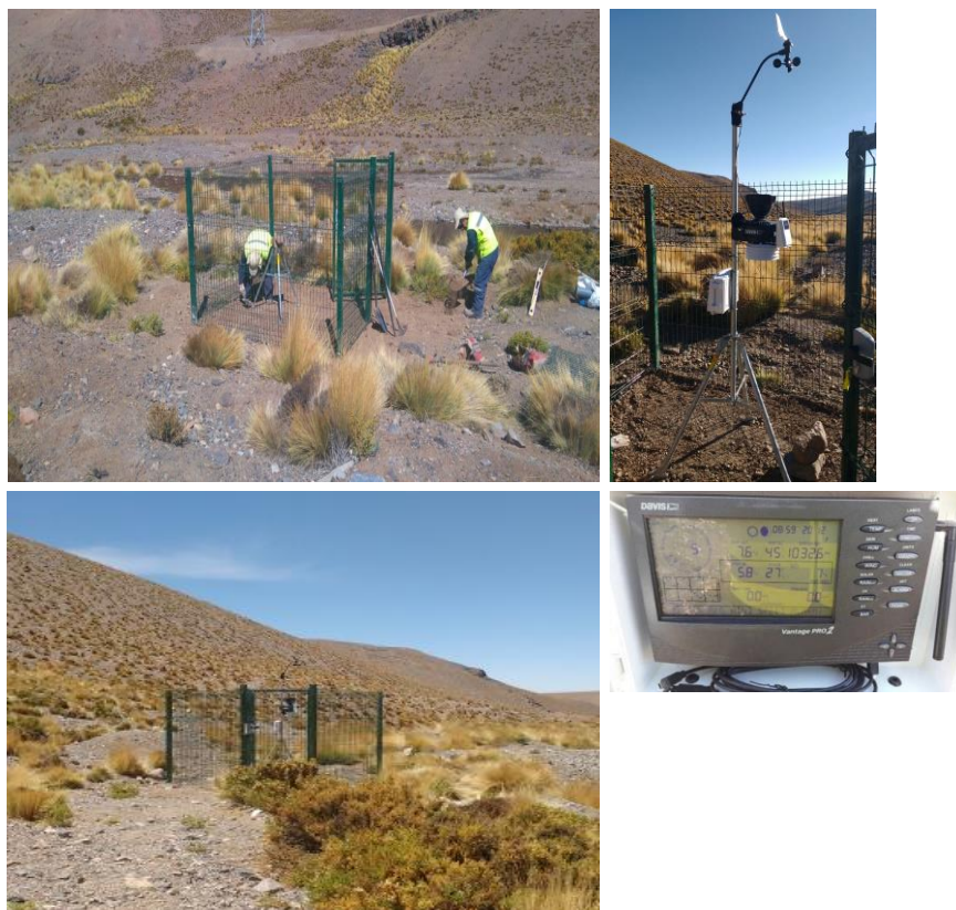
Fotografías 14 a 17. Instalación estación meteorológica.
